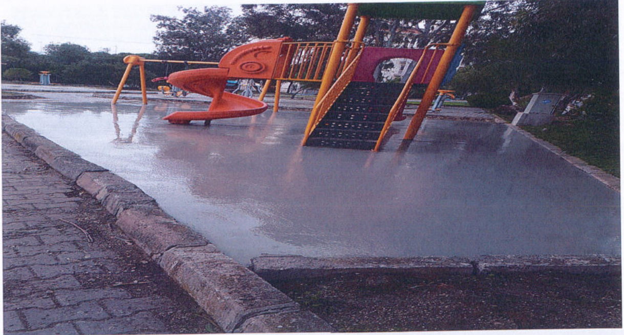
İhale kapsamında beton dökülen çocuk oyun alanı.
